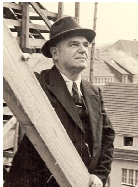
Heinrich Wurster 1950 auf der Baustelle des Bankgebäudes in der Kaiserstraße.
